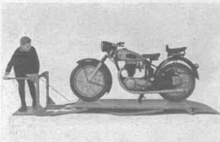
Diese Abbildung zeigt, die gesenkte Tischbühne, mit der zur Aufladung dienen den geklappten Verlängerung.
